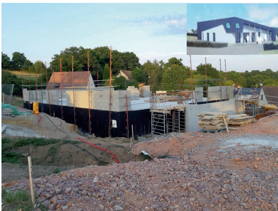
Chantier de la future clinique vétérinaire
