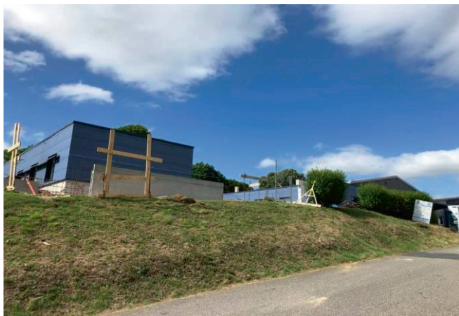
Futurs bureaux de la S.A.S.I.C
